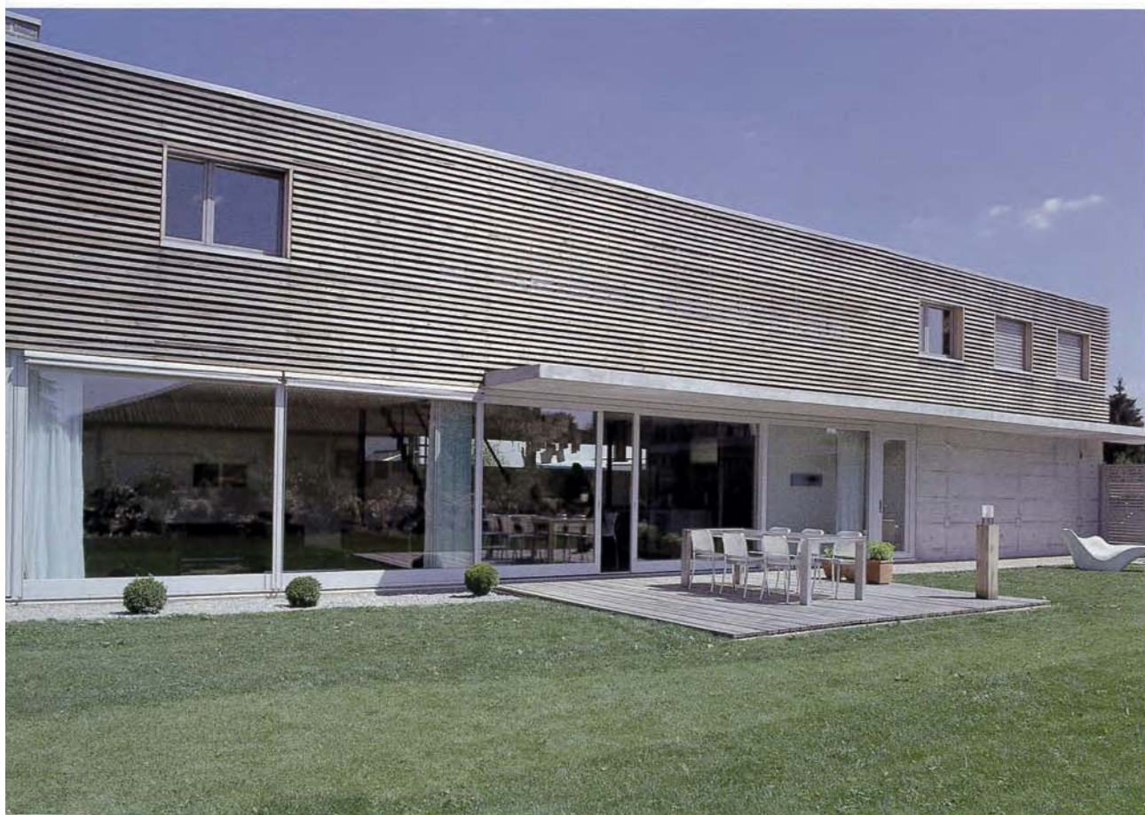
Dank der grosszügigen Schiebefenster verschmelzen innen und aussen zu einem geräumigen offenen Lebensraum.
